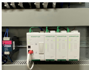
Schaeffler ProLink CMS im Schaltschrank.
