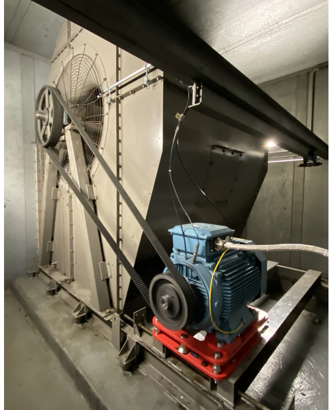
Lüfter mit patentiertem 3D-Motorschlitten und Zahnriemenantrieb im Werk des Automobilherstellers
